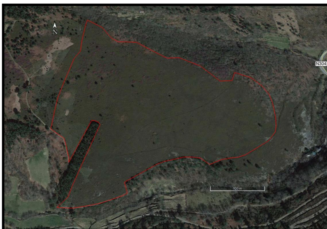
Figura 3 - Baldio de Aveção do Cabo – Área da Experiência Piloto (vista aérea)
